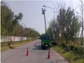
ซ่อมแซมไฟฟ้าสาธารณะในเขตตำบลกุดพิมาน (วันที่ 2026-03-10) [ผู้อ่าน 52]
